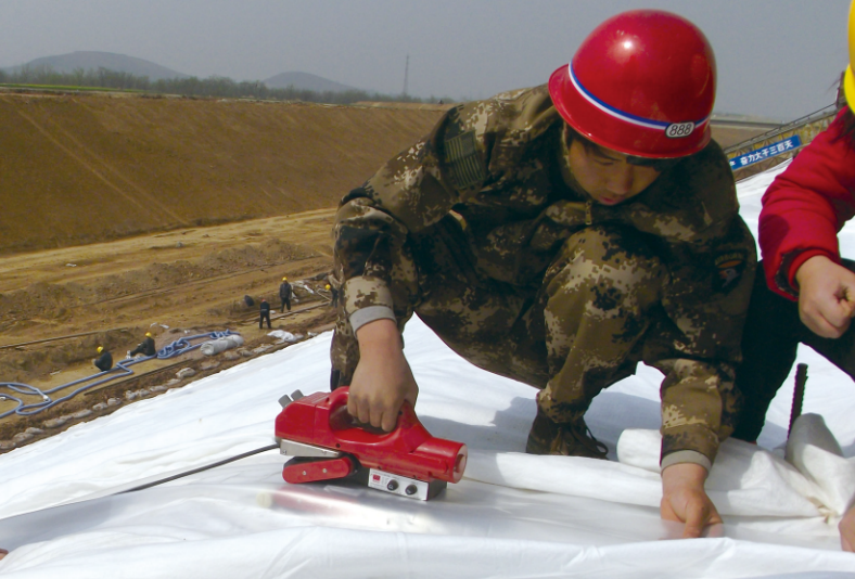
▲ 复合土工膜材料焊接, 南水北调工程 LST800
