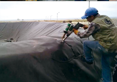
▲ 土工膜的修补焊接 LST610B
