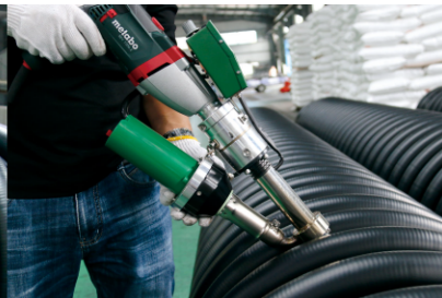
▲ 塑料管道的焊接 LST610C
