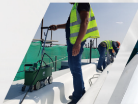
焊缝贴近天沟边沿焊接
