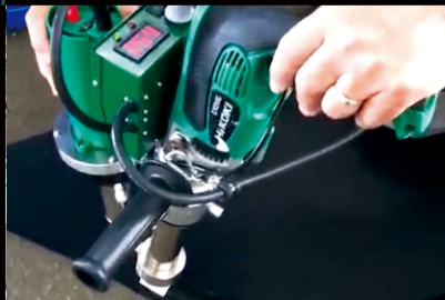
▼ 土工膜的修补焊接 LST600A
