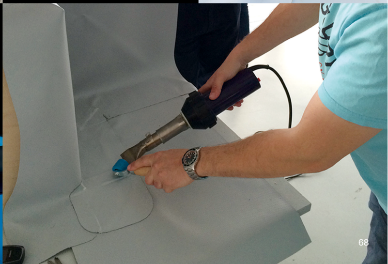
▼ 屋面TPO材料阴阳角修补焊接 LST1600A
