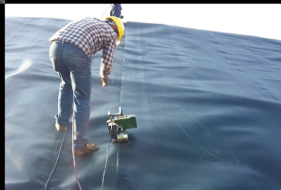
▼ HDPE (1.5mm) 膜材焊接, 尾矿现场 LST-GM1
