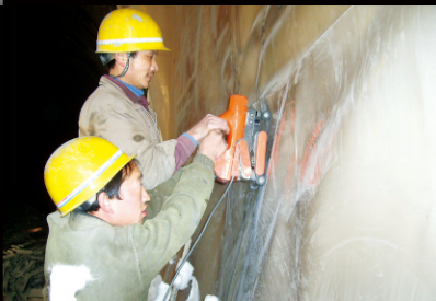
▼ 隧道防水板焊接 LST800
