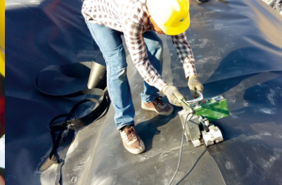
▲ HDPE (2.0mm) 膜材焊接, 垃圾填埋场 LST900
