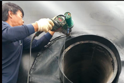
▼ HDPE土工膜的修补焊接 LST610A
