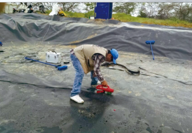
▲ HDPE (1.0mm) 膜材焊接, 人工湖项目 LST800D
